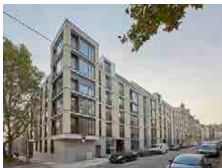
图13 罗特街新建建筑街景 Fig.13 New buildings along Roetestrasse 资料来源:德国CIP公司拍摄。
