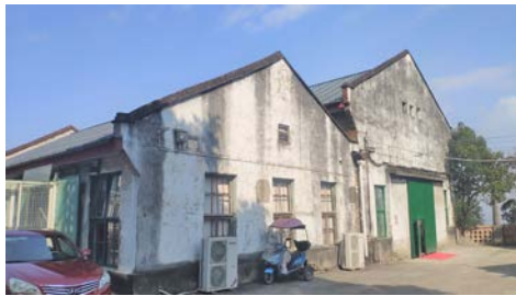
图7 816核工程的生活区建筑 Fig.7 Living quarters of 816 Project
