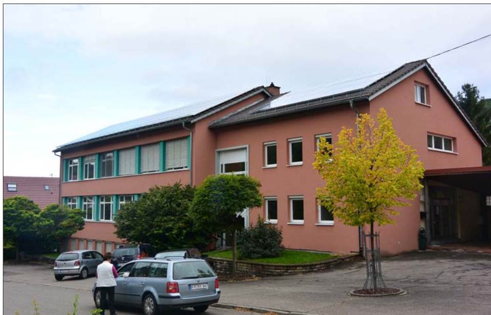
图8 改造中的村庄文化功能综合体建筑
